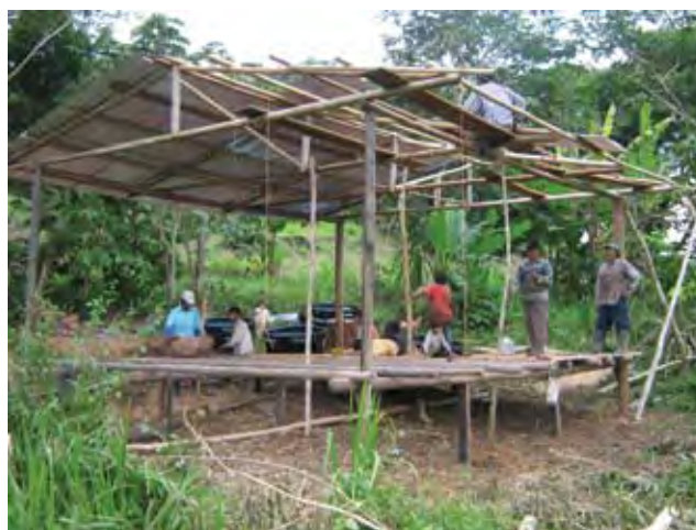
Figura 4.1. Proceso de construcción
