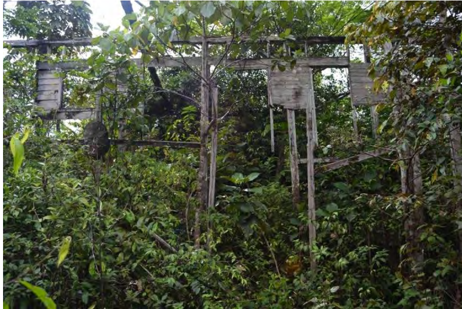
Figura 43 Restos de la estructura de la escuela en la finca de Tiobarbas
